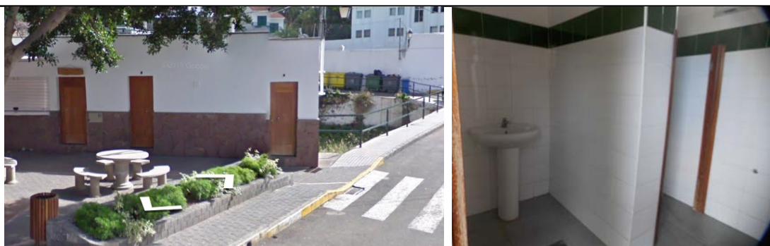
Fotos: Plaza, Interior de los baños
