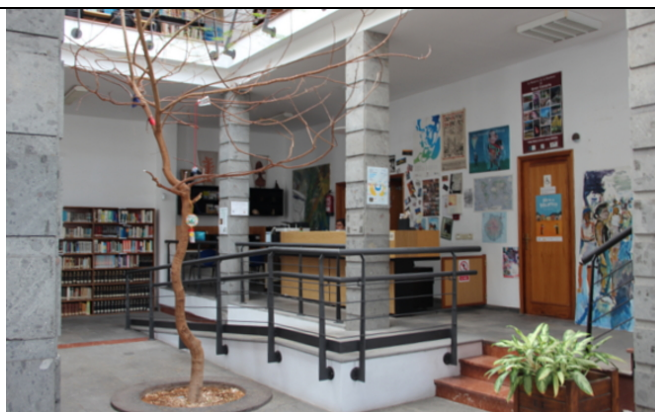
Fotos: Rampa de acceso al mostrador.
