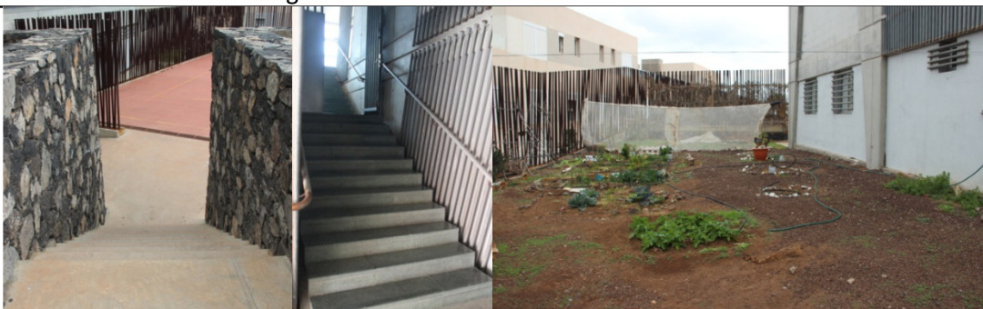
Fotos: Escalera exterior sin barandilla, escalera interior mal iluminada y zona de huerto.
