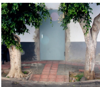
Fotos: Salida de emergencia con rampa
