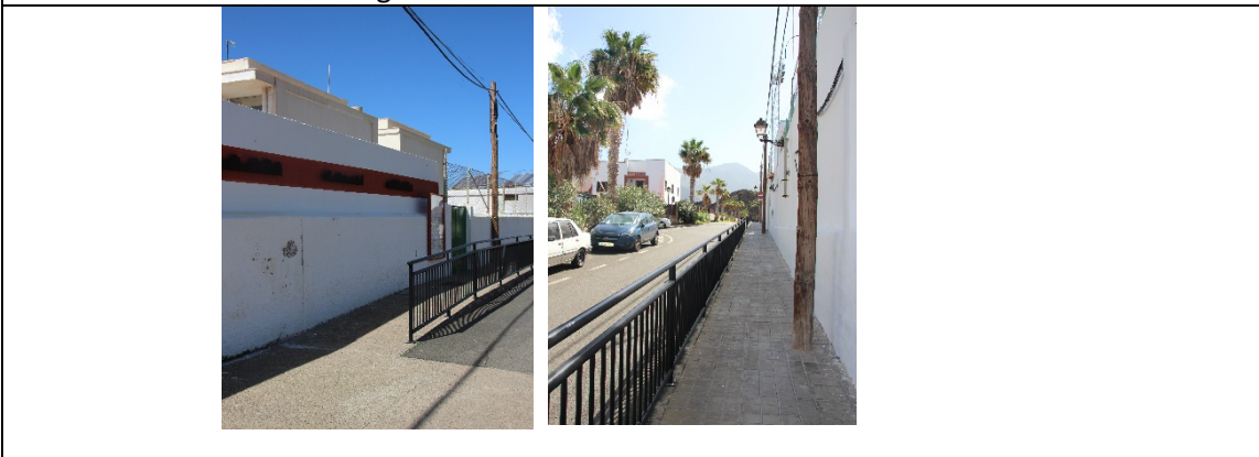
Fotos: Barandilla seguridad colegio
